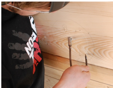
Rissestanga bøyes først til riktig radius, og tres inn i pilothullet. Da kan man merke av hvor hullet skal være.
