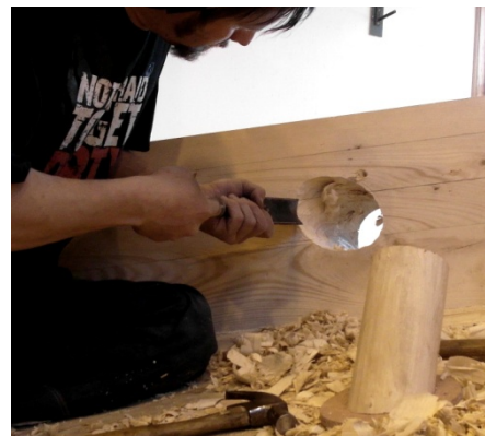
Fintilpasning. Boremalen vises nede til høyre.
