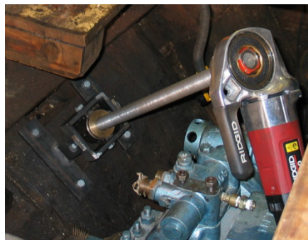
Bærbar gjengemaskin brukt til å drive rundt stanga. Vi ser også det fastmonterte stativet.
