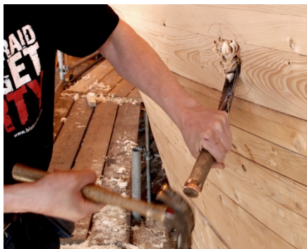
Etter hvert som man har tilstrekkelig mange hull kan man begynne å tappe ut trevirket som skal vekk.
