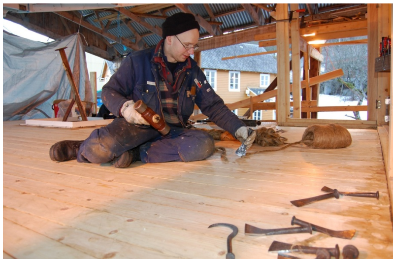
Driving av dekk med et utvalg av drivjern i forgrunnen.
