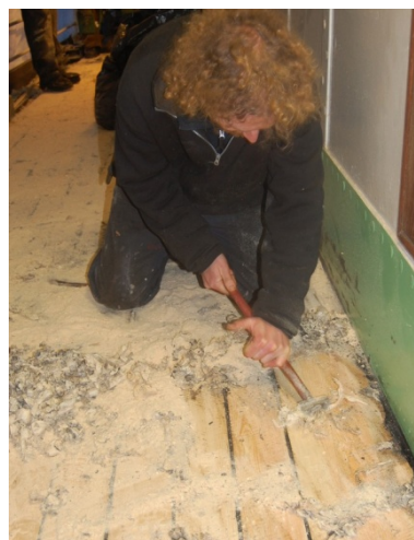
Dersom en strør sagflis utover dekket under skraping vil mye av beket fanges opp og en får et finere resultat med mindre søl av bek.
