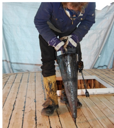
Bekhøna i drift. Ved første gangs beking er det viktig at beket er tilstrekkelig oppvarmet. Beket skal brenne seg fast i drevet.
