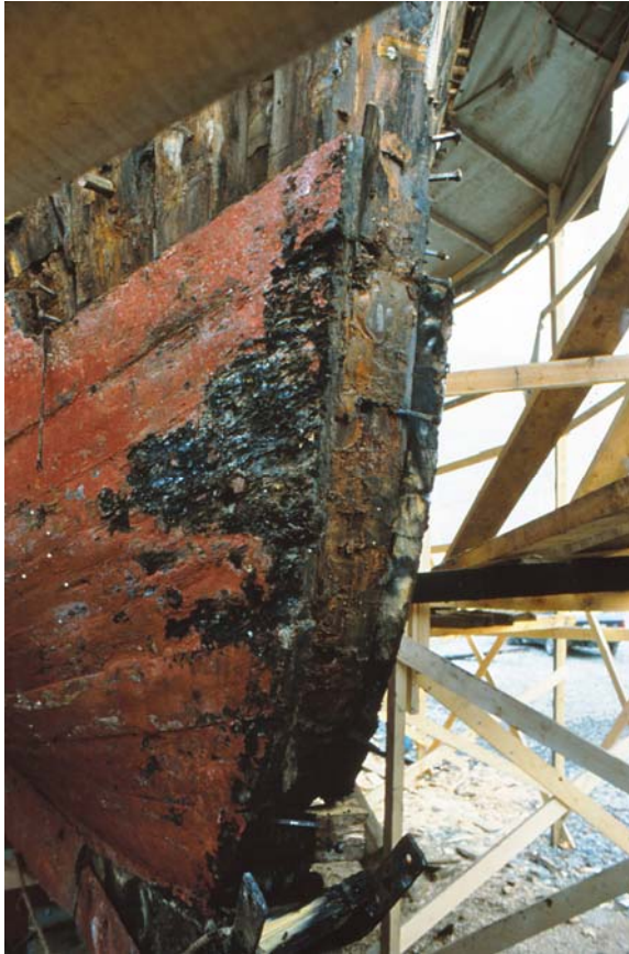
Stevnen er fjernet. Hudplankene i baugen var ikke i altfor god stand. Foto:HFS
