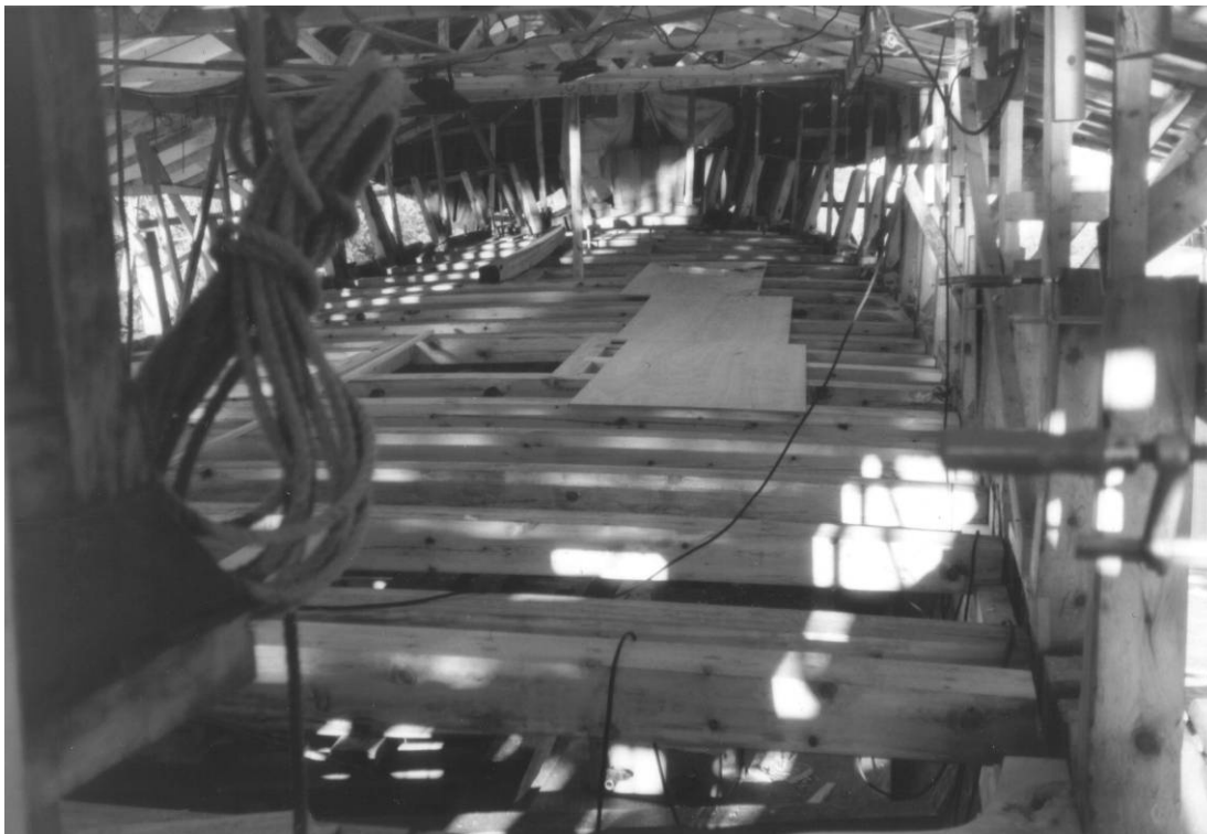
De nye dekkbjelkene er på plass. Foto: HFS
