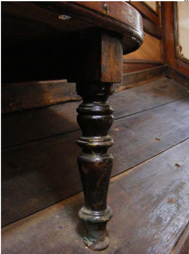
Dreide ben på sittebenk i forsalong. Benet står på 20 mm eikegarnering
