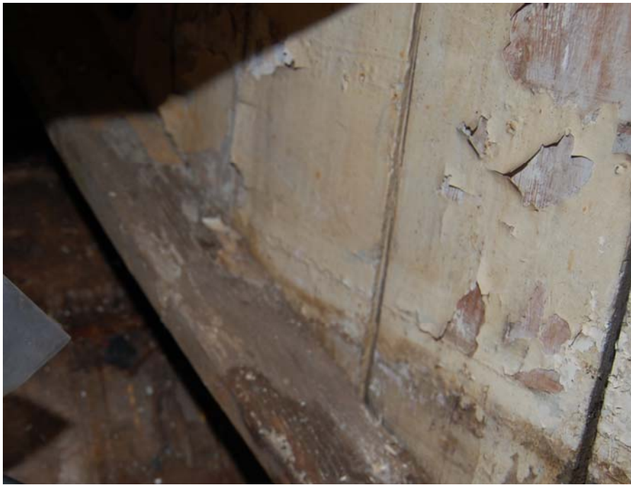
Bilde av skott i skap i salong akter. En ser den liggende list som endene av skottet er samlet på.
