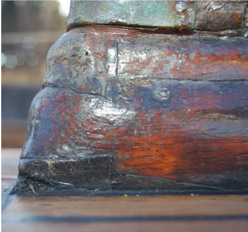
Hjørnesamling i bunnrammen på forluken. Tilsvarende samlinger fins i forkant på bunnrammen til overbygget.
