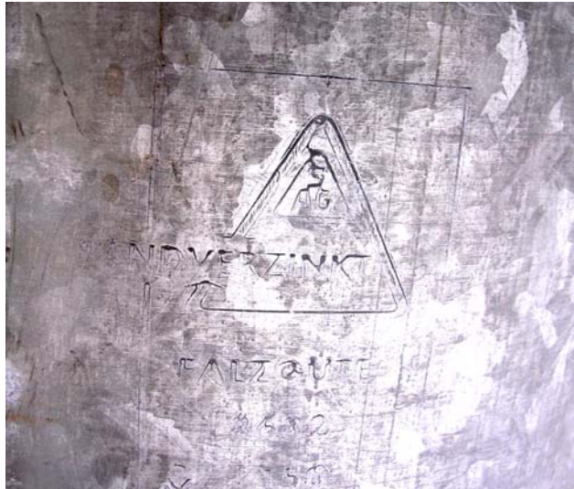
Tysk produksjonsmerke på galvanisert plate på lufthette fra Øya Verksted, ved Brevik bymuseum. Firmanavnet "SAG" skimtes øverst og teksten "Handverzinkt Falzgute" under. (Foto: Endre Wrånes).
