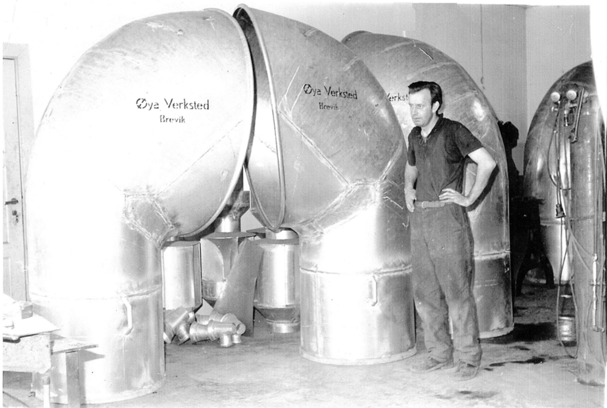
Leif Gulliksen foran 32-tommers lufthetter på Øya Verksted en gang på 1960-tallet. Størrelsen på hettene ble angitt ut fra diameteren på lufrøret de skulle festes på. Disse lufthettene var de største som ble produsert ved Øya, og ble levert til Bergens Mekaniske Verksted. (Foto: Harry Skui).
