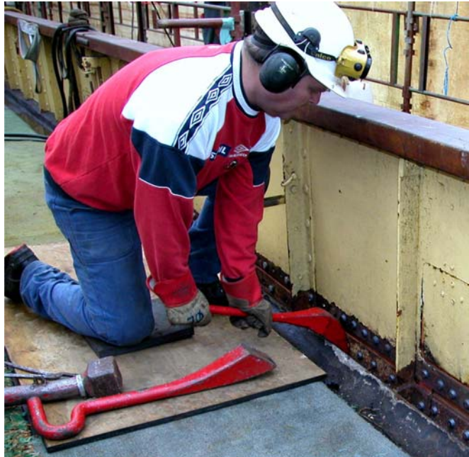
Mothold ved klinking av bindevinkel. Motholderen har flere mothold for hånden, men har valgt det mest hensiktsmessige for oppgaven
