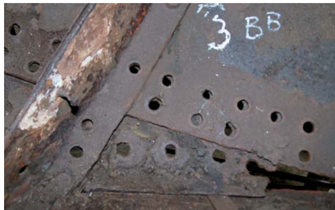
Platesammenføyninger med flere eksempler på saksing mellom platene
